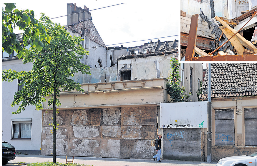
Fast die Hälfte der Schrottimobilie an der Hastedter Heerstraße steht noch. Versteckt wird der Schandfleck hinter einer Holzwand. Das kleine Foto zeigt einen Blick hinter die Bretter. Fotos: Schlie
